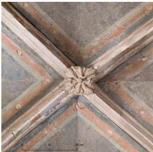
Abb. 30 Göttsweigerhof-Kapelle, Stein an der Donau. Detail des Schlusssteins im Bereich des Kreuzrippengewölbes im Kapellenraum. Digital elevation model (DEM) kombiniert mit einem true orthophoto (überlagert). Fotos: Peter Böttcher 2016; Modell: Gábor Tarcsay, Michaela Zorko 2017
