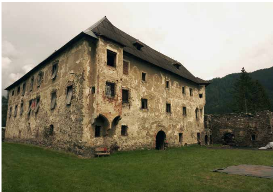
Abb. 3 Schloss Hanfelden, Westfassade und Südfassade mit Südtor sowie noch ungedecktem Nebengebäude (Foto: Claudia Theune 2016).
