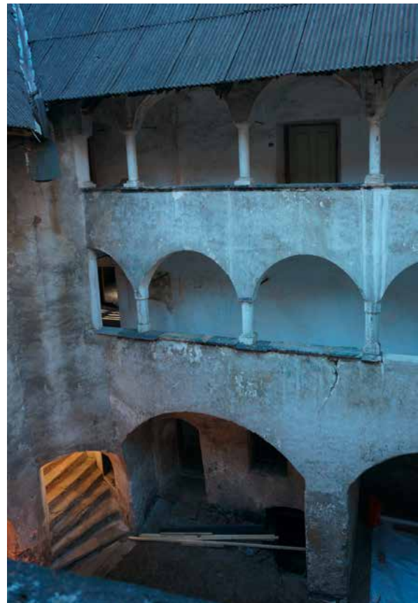
Abb. 7 Schloss Hanfelden, Arkadenhof mit eingestelltem Treppenhaus, Ansicht vom Arkadengang des Ostflügels im zweiten Obergeschoss (Foto: Claudia Theune 2016)
