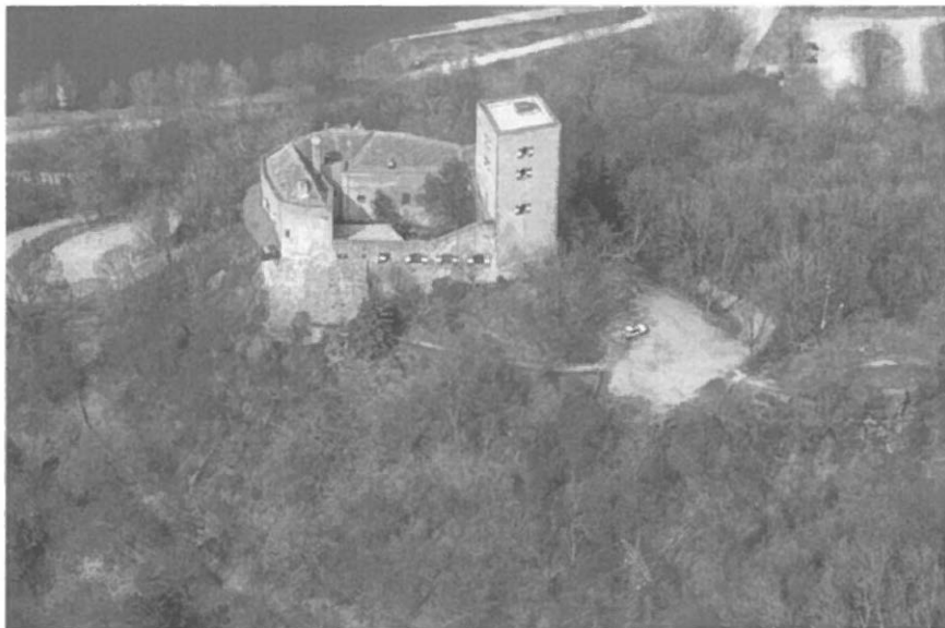
Abb. 7: Greifenstein. Luftbild von Süden.
