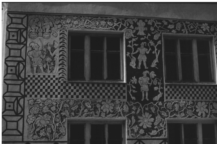
Abb. 176: Weitra, Rathausplatz 48: linker Hausteil
