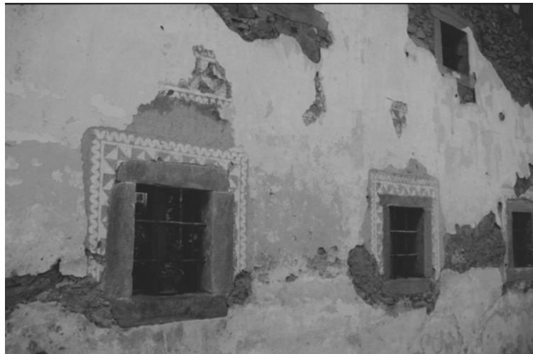
Abb. 445: Oberschlierbach Nr. 85, Fensterumrahmungen
