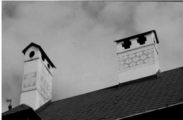
Abb. 474: Schloss Niederdorf: Kamine mit Rautenfriesen und Diamantierungen
