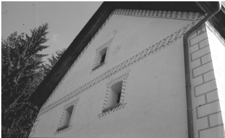
Abb. 362: Stainach, ehemaliger Zehenthof des Stiftes Admont, Fries und Eckquaderung
