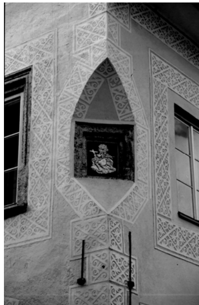
Abb. 375: Weyer, Unterer Markt 6, Eckquaderung und Fensterumrahmungen
