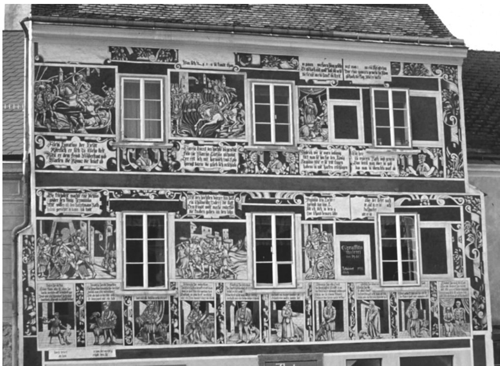
Abb. 161: Weitra, Rathausplatz 4, Gesamtansicht
