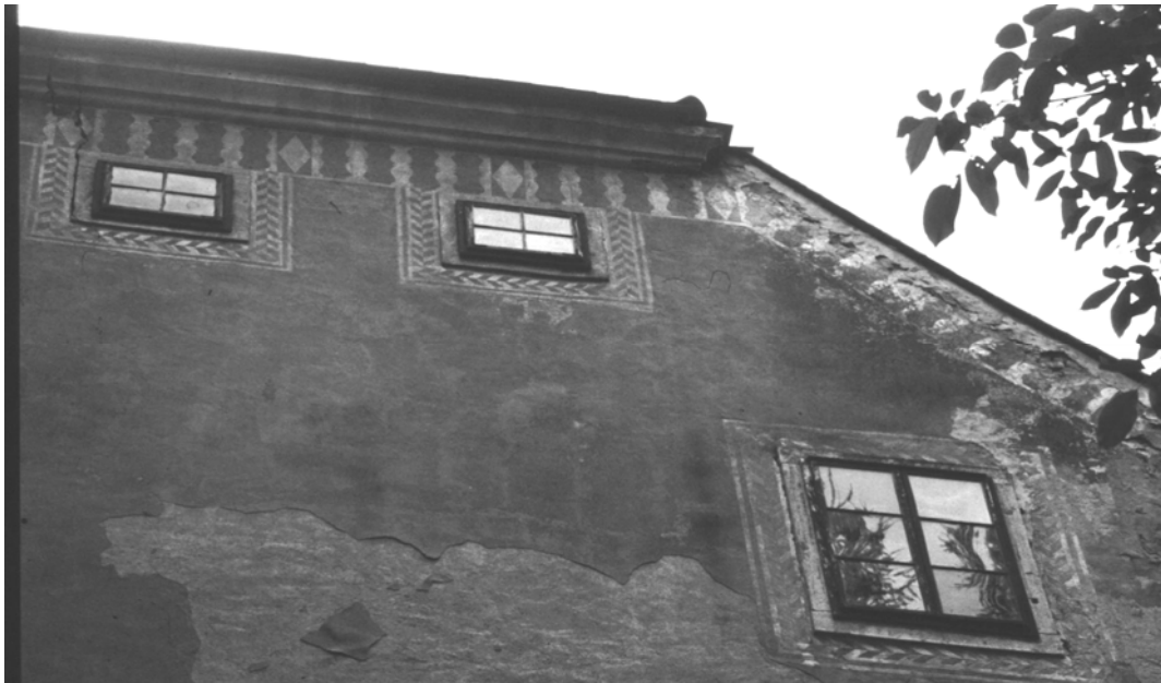
Abb. 544: Schloss Pottschach, Balustrade und Fensterumrahmungen
