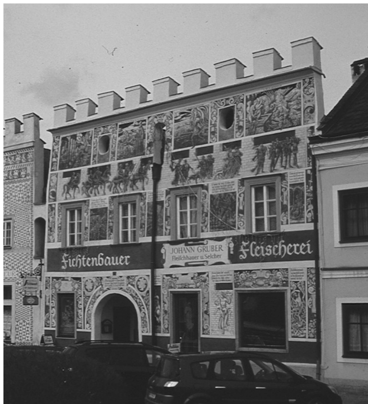
Abb. 83: Gmünd, Stadtplatz 33, Gesamtansicht
