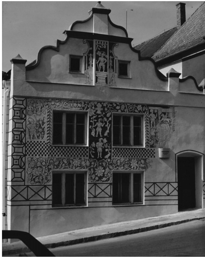
Abb. 175: Weitra, Rathausplatz 48: Gesamtansicht
