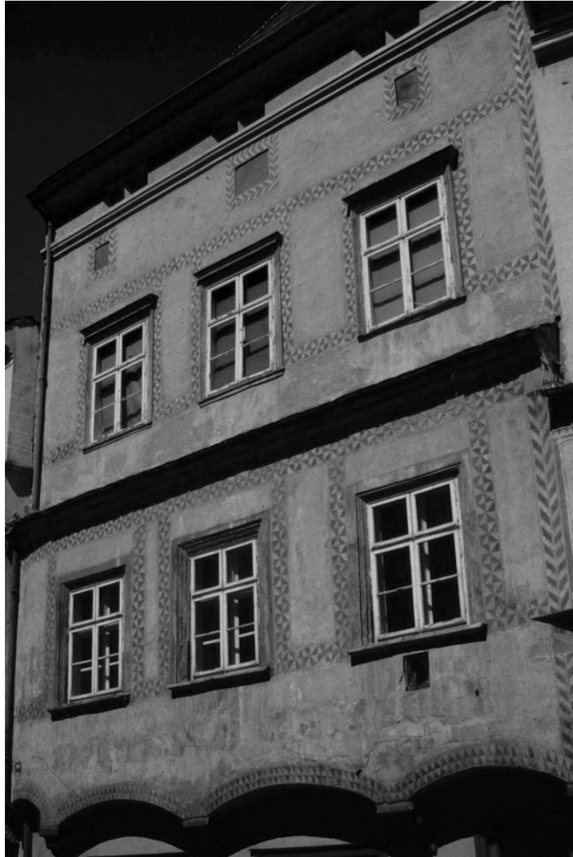
Abb. 130: Krems, Untere Landstraße 69, linker Hausteil
