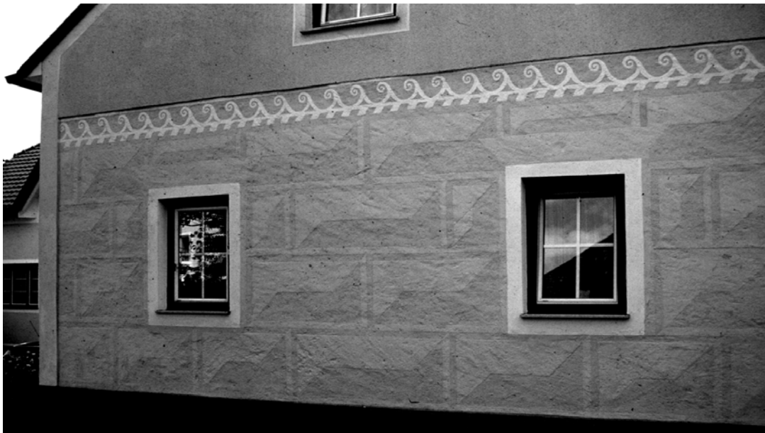
Abb. 355: St. Peter in der Au, Bachviertelstraße 4, Briefquader
