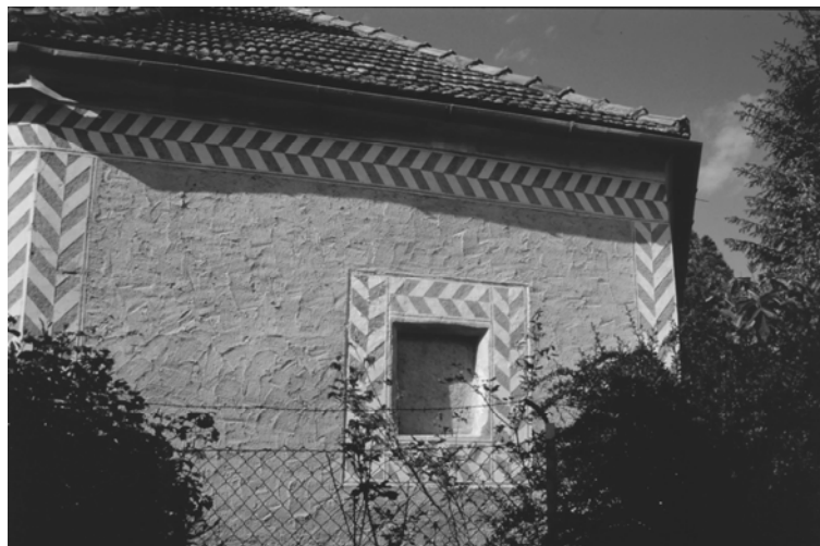
Abb. 299: Weißenkirchen Nr. 54, Nebengebäude mit Bändern in Fischgrätmuster
