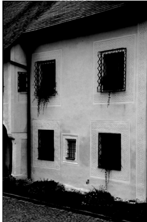
Abb. 378: Weyer, Nach der Enns 25, Friese und Fensterumrahmungen
