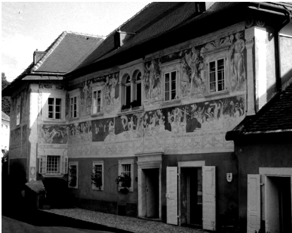
Abb. 61: Althofen, Riederhaus, Gesamtansicht
