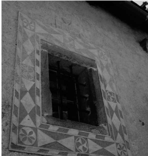
Abb. 218: Burg Rappottenstein, Nebengebäude, Fensterumrahmung
