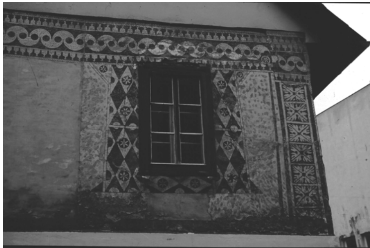
Abb. 350: Mautern Nr. 100: Bänderung und Fensterumrahmungen
