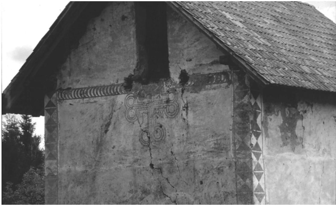
Abb. 464: Hart ob Steuerberg, Speicher bei Nr. 2
