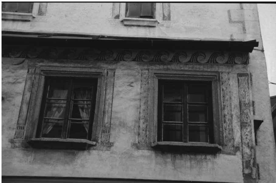
Abb. 253: Enns, Bäckergasse 1, Fensterumrahmungen
