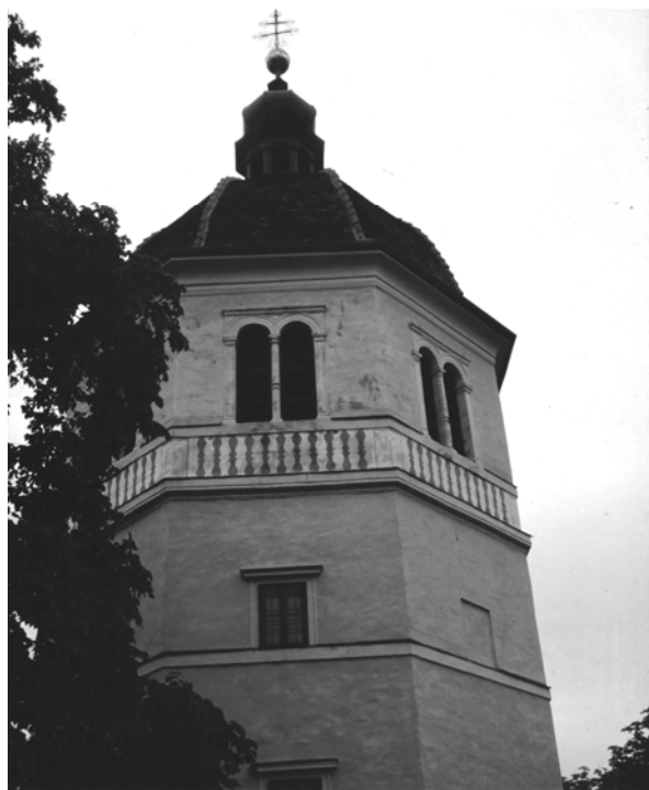
Abb. 503: Graz, Glockenturm, sgraffitierte Balustrade
