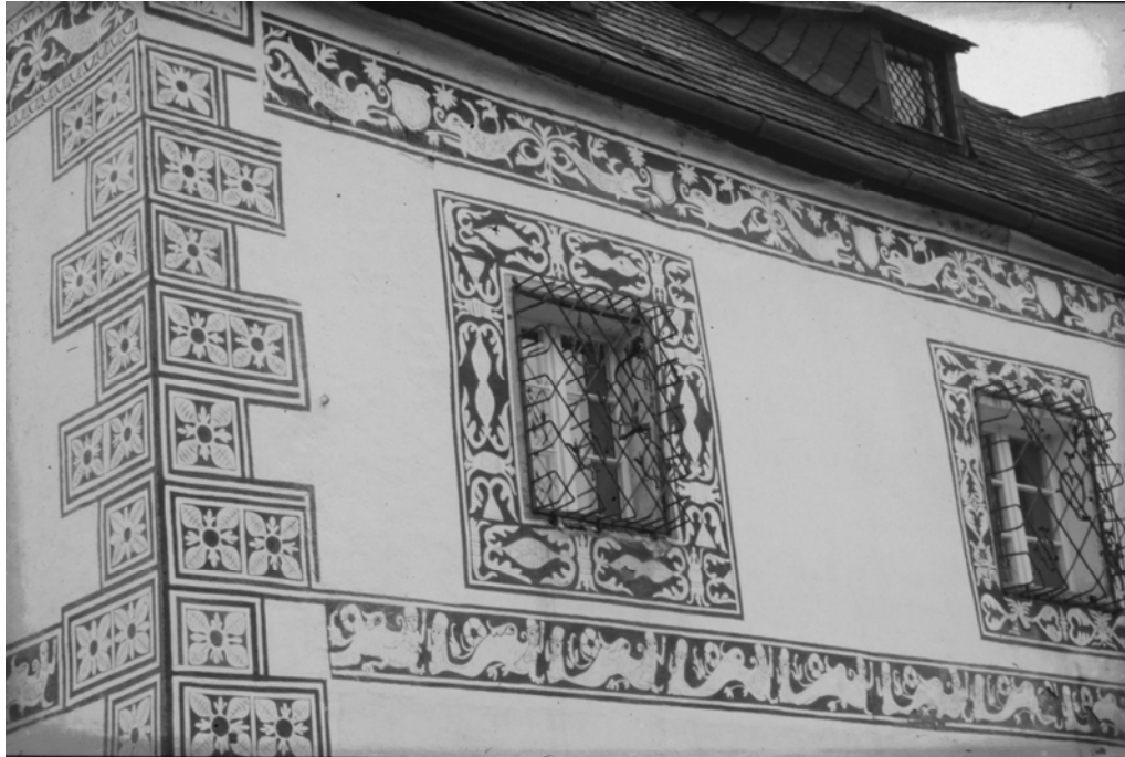
Abb. 346: Lunz, Amonhaus, Frieze und Fensterumrahmungen
