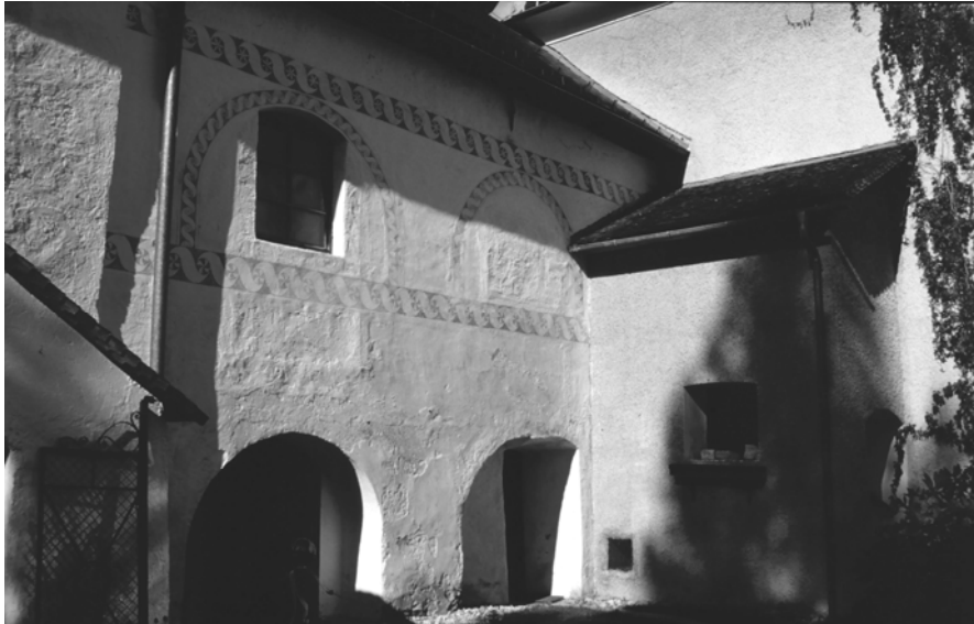
Abb. 337: Haus im Ennstal, ehemaliger Zehentspeicher
