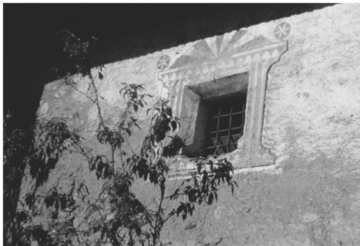
Abb. 472: Köstendorf, Speicher bei Nr. 25, Scheinarchitektur
