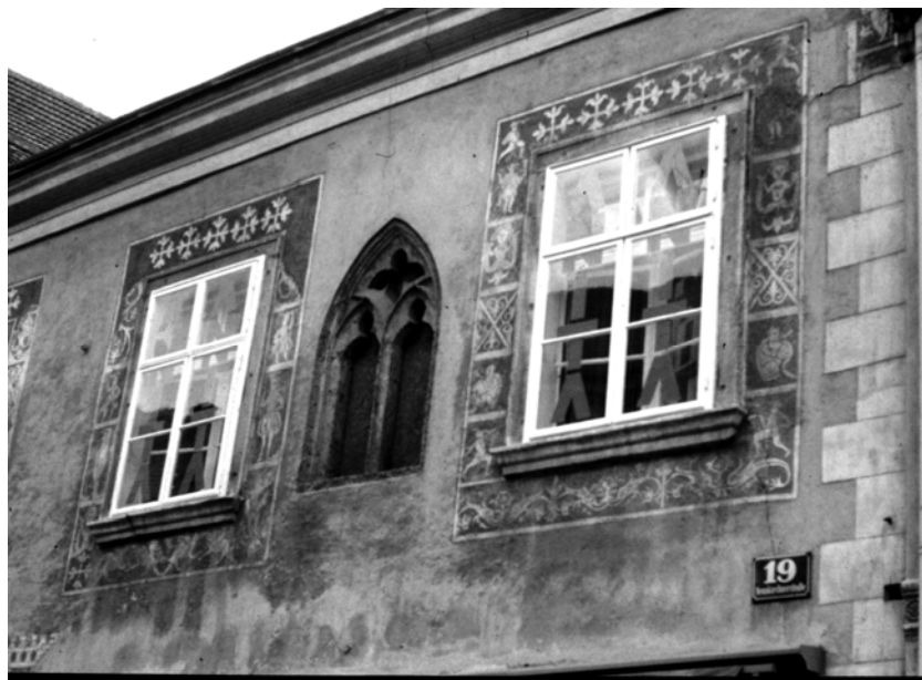
Abb. 557: Wiener Neustadt, Neunkirchnerstraße 19, Fensterumrahmungen
