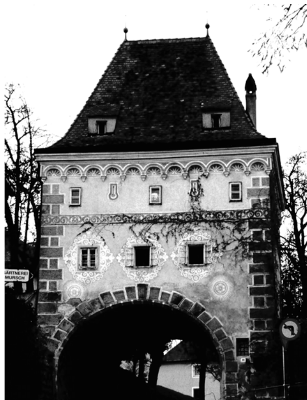
Abb. 398: Steyr, Gleinkergasse 46, Schnallentor, Fensterumrahmungen und Sonnenmotive
