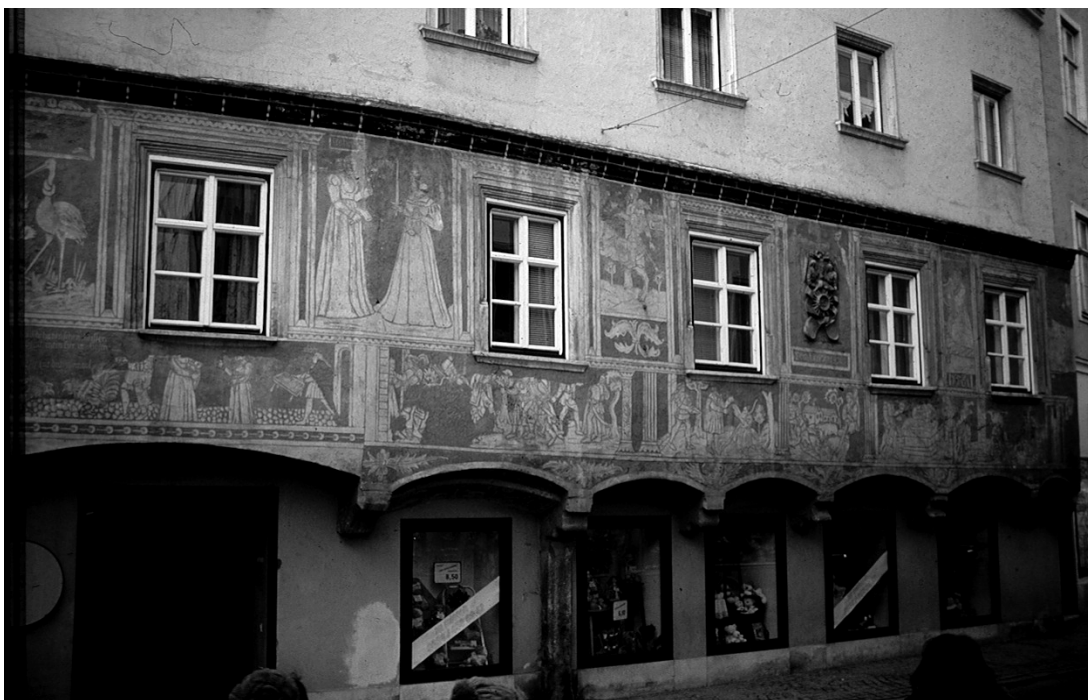
Abb. 123: Krems, Untere Landstraße 69, Gesamtansicht
