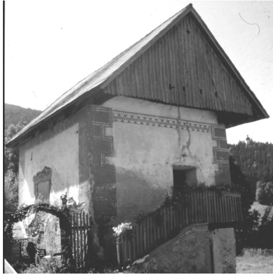
Abb. 307: Admont, Speicher bei Nr. 93, Fries und Eckquaderung
