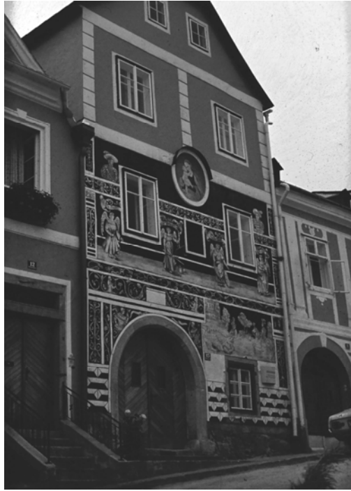
Abb. 171: Weitra, Rathausplatz 13, Gesamtansicht
