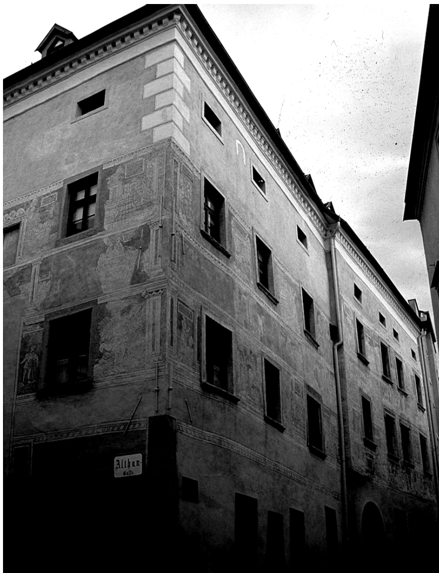
Abb. 110: Krems, Margarethenstraße 5, Gesamtansicht
