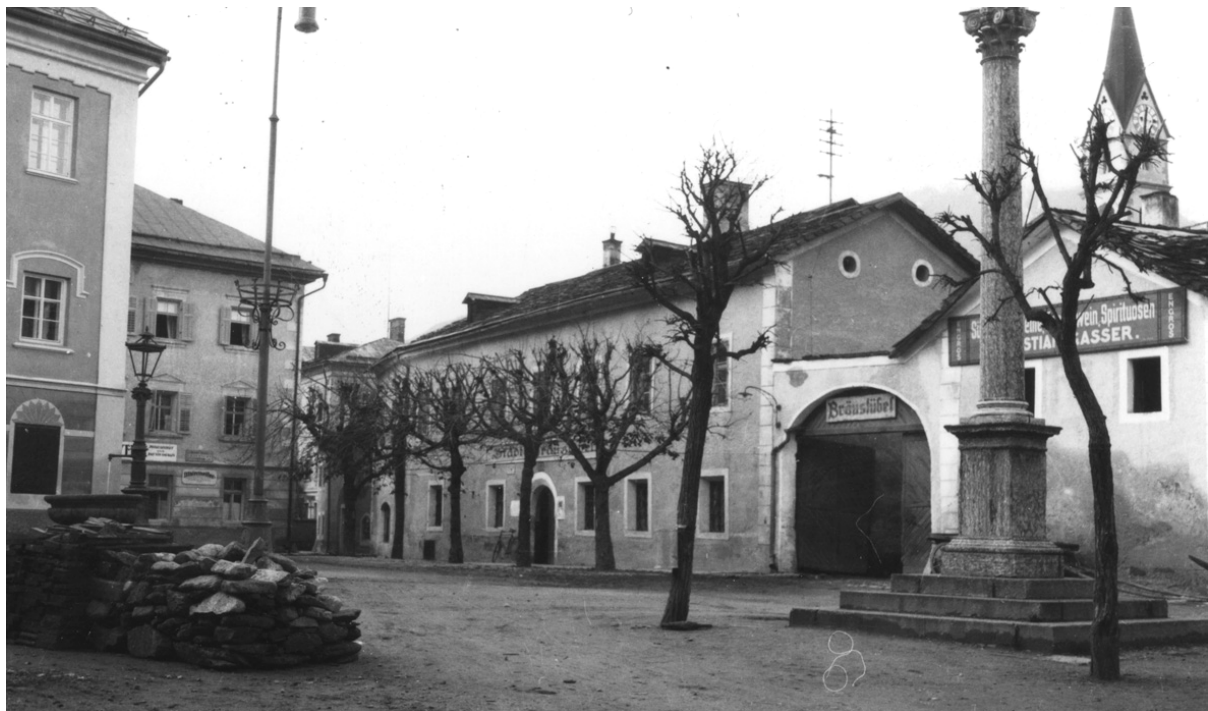
Abb. 26: Johannesplatz, um 1928; Blick in Richtung NW auf das ehemalige Mesnerhaus von St. Johann, das bis zum Ende des 18. Jahrhunderts als solches diente; später gehörte es zum Komplex des Stadtbrauhauses (heute Lienzer Sparkasse) (Fotosammlung M. Pizzinini). Foto: Franz Baumann
