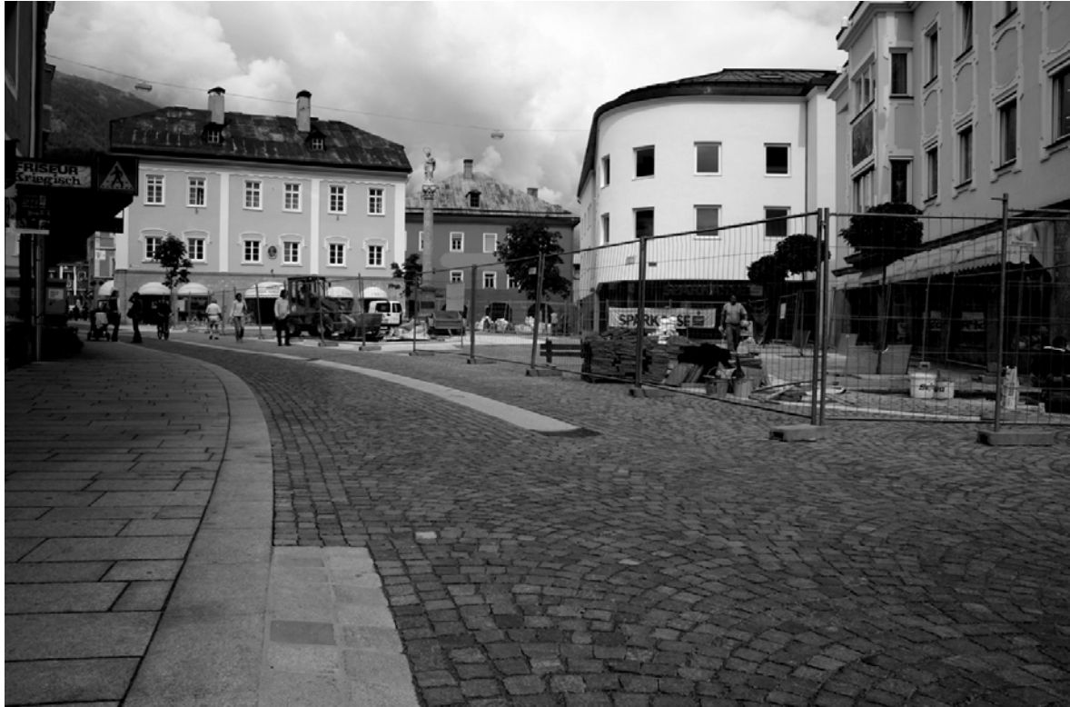
Abb. 3: Der Lienzer Johannesplatz während der Sanierungsarbeiten im Frühjahr 2005. Foto: Stadtgemeinde Lienz, Bauamt
