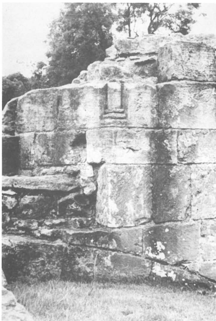
Abb. 19: Roche, Westflügel: Innenansicht der Südwand mit Gewände des östlichen Fensters
