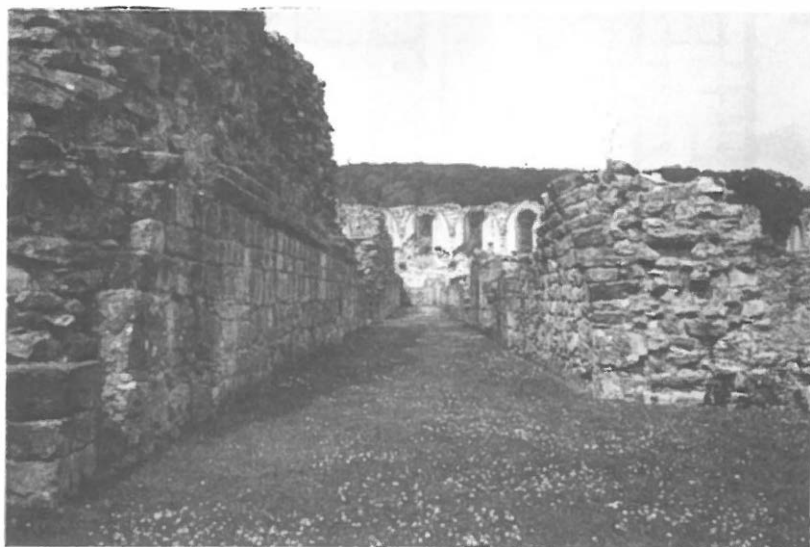
Abb. 8: Byland, ‘Konversengasse’; Blick nach Norden
