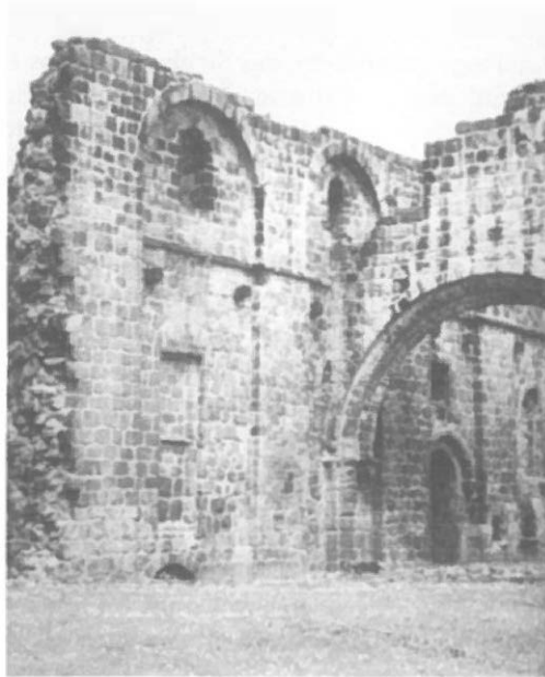
Abb. 17: Kirkstall, Westflügel: südliche Joche der Ostfassade mit Torbogen zum ehemaligen Korridor
