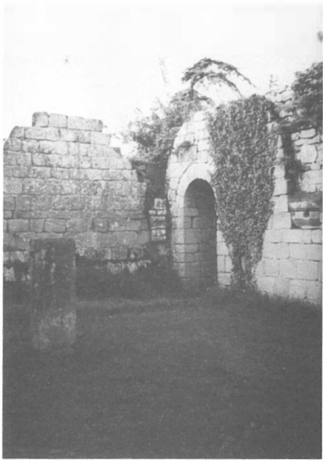
Abb. 25: Jervaulx, Westflügel: nordöstliche Ecke mit Klausurdurchgang
