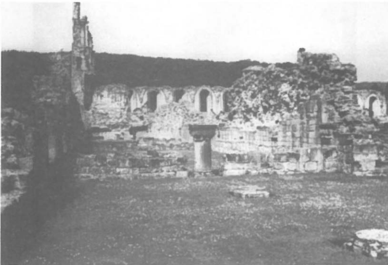
Abb. 27: Byland, Westflügel: Trennwand zwischen dem südlichen und mittleren Raum, Blick nach Norden
