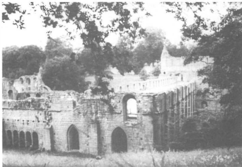
Abb. 16: Fountains, Westflügel: Südseite mit Latrinblock
