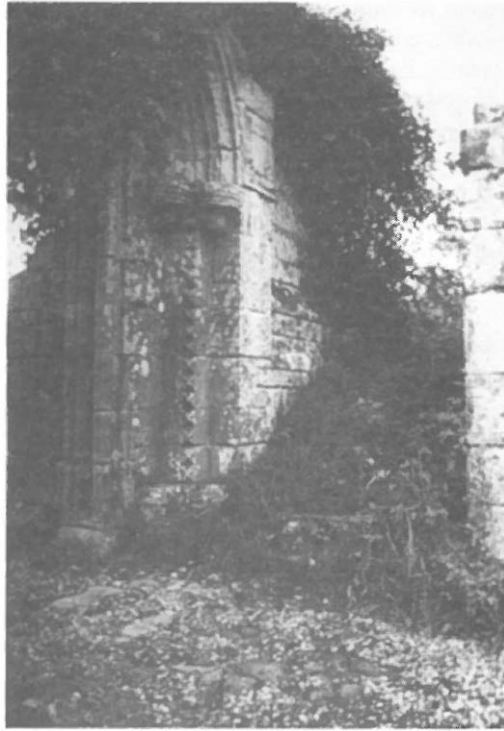
Abb. 37: Jervaulx, Westflügel: Treppenlauf und Portal ins südliche Langhaus
