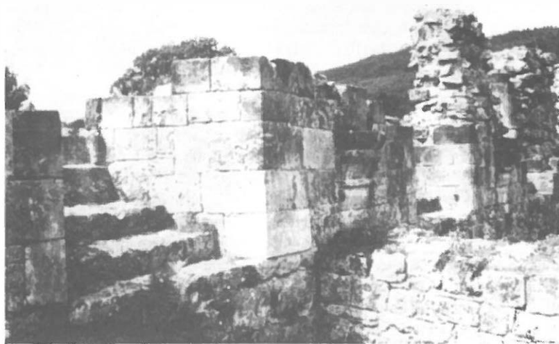
Abb. 18: Byland, Westflügel: Innenansicht der Westwand im 12. und 13. Joch von Norden
