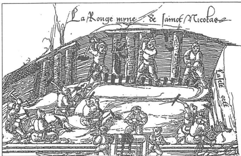
Abb. 10: Gewinnungsarbeit: Im Hintergrund Bergleute bei der Hereintreibearbeit, im Vordergrund die Schlägel- und Eisenarbeit (Bergbuch der Myne Rouge)
