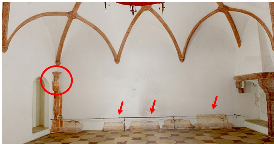
Abb. 29 Verortung des Terrakotta-Elements in Abb. 28 (Kreis) in der Nordostecke des Weißmarmorsaals und weitere in situ Reste der Wandverkleidung (Pfeile). Screenshot aus 3D-Raummodell.
