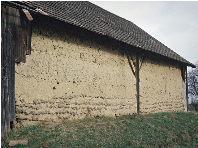
Abb. 7 Scheune in Lehm-Pfostenkonstruktion in Roggendorf/NÖ.
