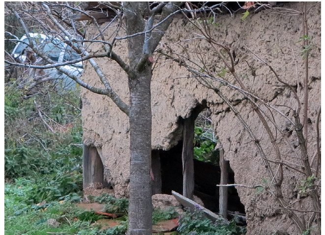
Abb. 8 Scheune in Lehm-Pfostenkonstruktion in der Rákóczi Ferenc utca in Ják in Westungarn nahe der burgenländischen Grenze.
