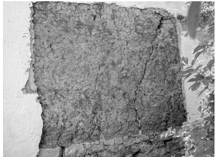
Abb. 4 Gesatzte Mauer auf Bruchsteinfundament in Windpassing/NÖ mit sichtbaren horizontalen Satz-fugen, welche auf die einzelnen Verarbeitungsabschnitte hinweisen. Innerhalb eines horizontalen „Satzes“ sind Anschüsse in Form von schrägen Versätzen sichtbar, die als Gleit-fugen relevante vertikale Risse in der „Satzlehm-mauer“ verhindern. Der Grund dafür ist, dass sie die starke horizontale Schwindung beim Trocknen eines „Satzes“ durch schräges Abgleiten zum größten Teil in einen technisch nicht relevanten Höhenversatz umwandeln, der vom darauf-folgenden „Satz“ ausgeglichen wird.
