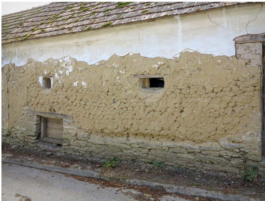
Abb. 6 „Lehmwuzelmauer“ auf einem Bruchsteinsockel in der Weinviertler Kellergasse in Wolfpassing (Nähe Hollabrunn)/NÖ.
