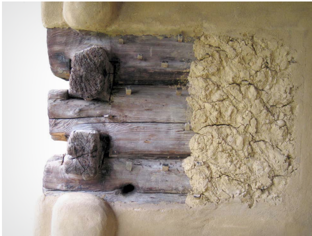
Abb. 11 Holzblockwand eines „Kitting“ Speicherbaus im Freilichtmuseum Vorau mit Holzkeilen als Putzgrund für den Grob- und Feinputz (sog. „Spicktechnik“).
