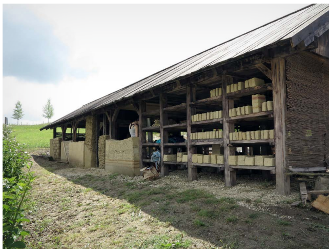
Abb. 2a Die im Weinviertel bekannten traditionellen Lehm- bautechniken wurden im Rahmen der ARGE Lehm- bau vom Team auf der Lehm- baustelle im Museumsdorf Niedersulz/NÖ experimentell rekonstruiert.
