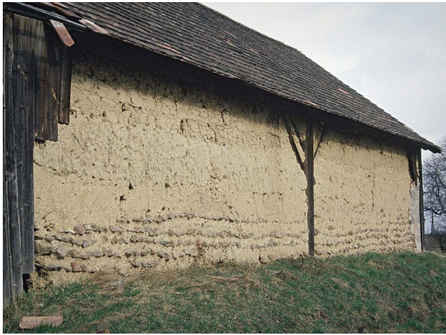
Abb. 7 Scheune in Lehm-Pfostenkonstruktion in Roggendorf/NÖ.
