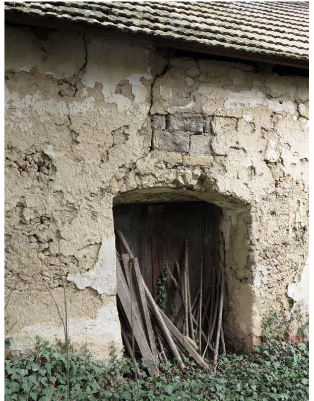
Abb. 9 Eine Scheune bei Windpassing bei Schöngrabern/NÖ zeigt einen Sturzbogen aus Lehmziegeln, darüber eine Nivellierschicht aus Lehmziegeln, welche wiederum als Auflager für das darüber befindliche „Quäderstockmauerwerk“ verwendet wurde.
